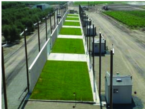
(d) Elevated view of the site
