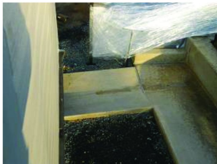
(d) Flow of runoff water to collection system
